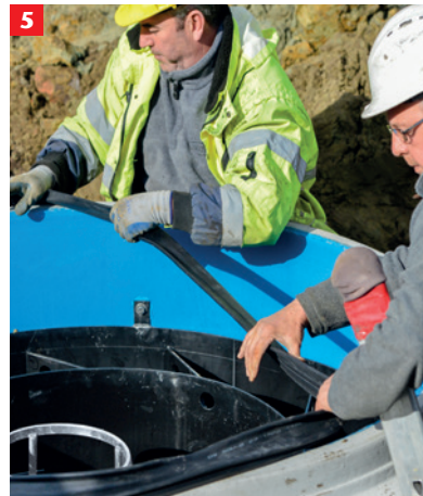
5 Montage der Gleitringdichtung
