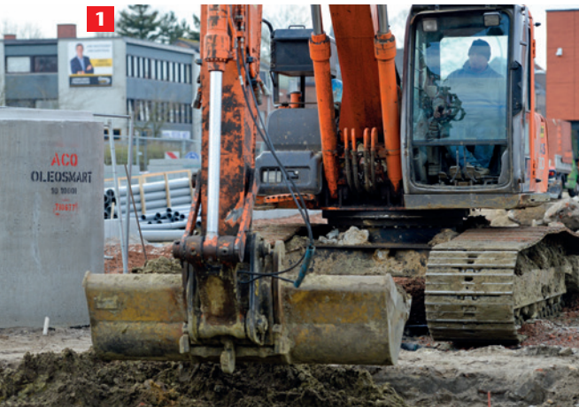
1 Ausheben der Baugrube
