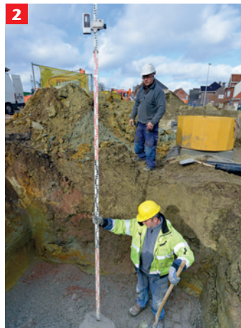
2 Tiefenkontrolle der Baugrube
