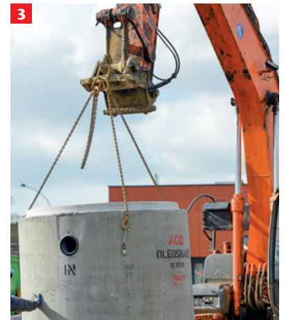
3 Setzen des Stahlbetonbehälters
