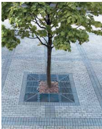
ACO WOTAN rešetka za zaštitu drveća - samonosivi sistem bez podkonstrukcije.
