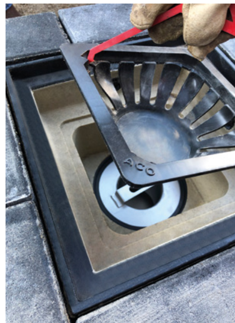
Leichtes Handling des Schlammeimers zum regelmäßigen Säubern
