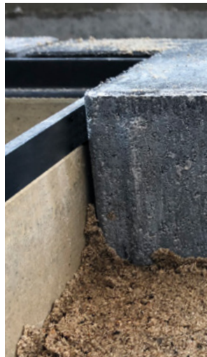
3–5 mm überhöht eingebautes Pflaster um den Ablaufkörper
