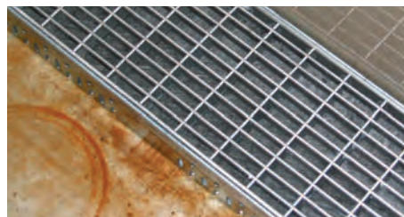
Umetnuta zaštita od prljavštine smanjuje hidraulične performanse sistema za 30% čak i u čistom stanju
