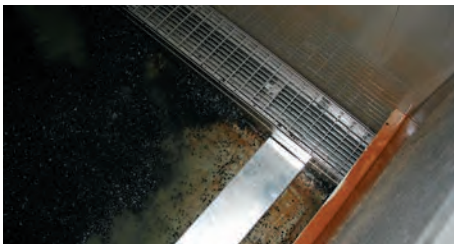
Probno postavljanje sa bočno postavljenim spojnim kanalom (bez izreza u telu kanala)
