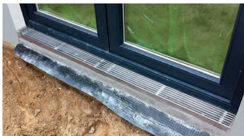
Jednodielni kanal se izrađuje tačno prema potrebnim dimenzijama
