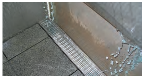
Irigacija kanala za odvodnjavanje fasada pri ugradnji
