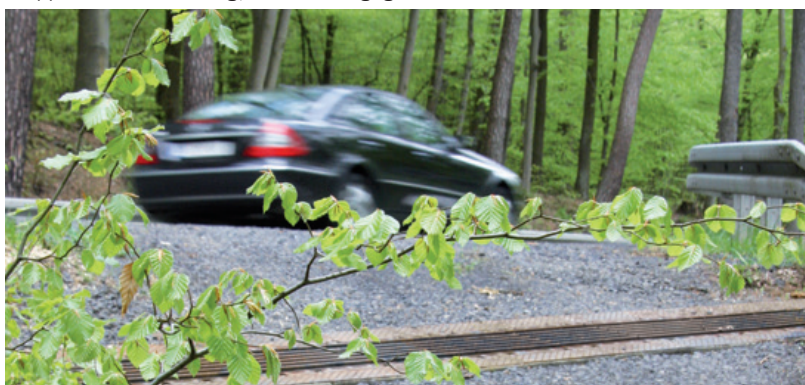
Stopprinne im Nebenweg, starkes Längsgefälle
