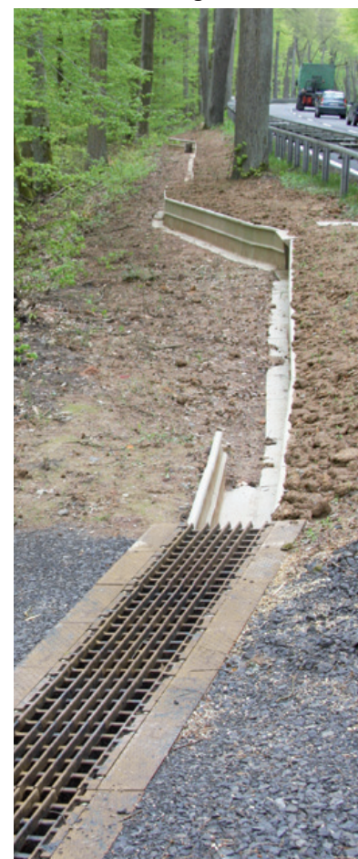
Einbau in Schotterwege
