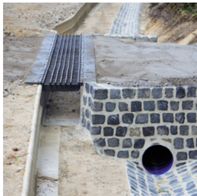
Sonderlösung: separate Wasserführung
