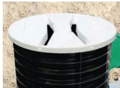
nekontrolisan dotok površinskih voda u Stormbrixx sistem, a kada je okno u zelenoj površini, koristimo poklopce sa otvorima za ventilaciju.
