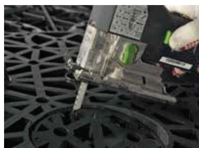
Izrezivanje otvora u bočnom panelu
