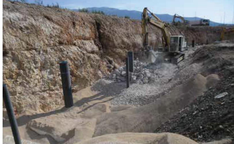
Zasipanje bokova se izvodi u slojevima od  $\leq 30$  cm prilikom čega se zasipni materijal mora ravnomerno dodavati oko celog sistema. Sabijati se sme samo upotreboom srednje teške opreme za sabijanje (najprikladnije: vibro ploče) do Proctorove zbijenosti  $D_{Pr} \geq 97\%$ .
