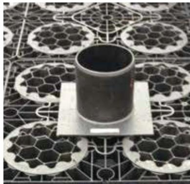
Kada se ugrade svi probušeni polublokovi, sistem se omota geotekstilom - kod retencije unutrašnji zaštitni sloj geotekstila, te se postavi cevni priključak DN 150.
