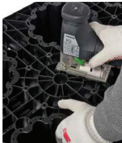
Konstrukcija bloka bez bočnih stranica (bočnih panela) koje se sastavljaju samo na rubovima sistema omogućava stvaranje sistema kroz koji je omogućeno slobodno kretanje inspekciione opreme i opreme za čišćenje (ako se odabere prikladan tip opreme) te znatno bolja preglednost samog sistema (ništa ne zaklanja pogled kroz inspekciione magistrale).
