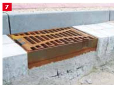
Sливник sa betonskom posteljicom, zakošen prema sredini saobraćajnice. Plastična rebra moraju obavezno biti ispunjena betonom.
