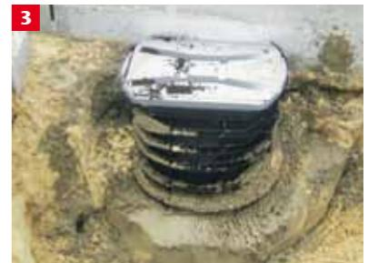
Donji deo se polazi na temelj od betona klase MB15 do prvog rebra elementa (označeno na elementu).
