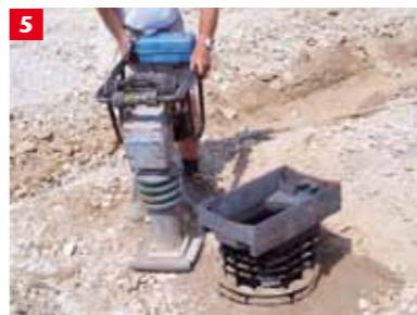
Zbijanje materijala sa lakšom mehanizacijom do natpisa „bottom of concrete“ na gornjem elementu.
