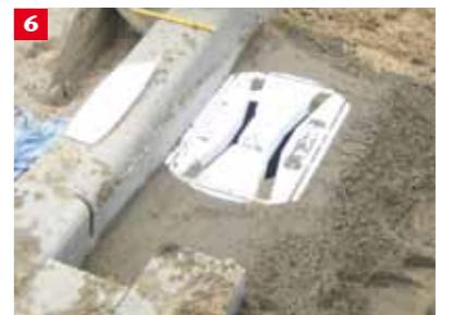
Betonska posteljica MB15 za rešetku izdignuta je za 2 cm iznad tela sливnika, uz pomoć EPS-Combi oplate.
