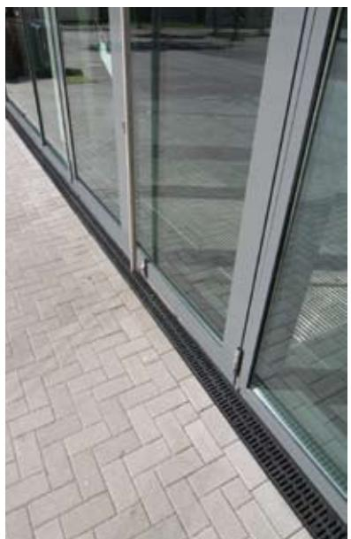
ACO XtraDrain elegantno rešenje odvodnjavanja fasada
