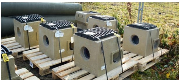
Tauchwandschächte bereit zum Einbau
