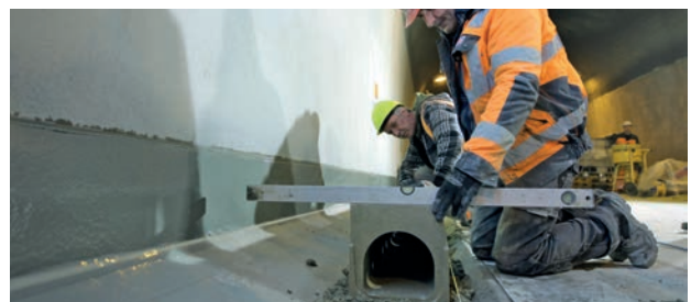
Ausrichten der Tunnelrinne, Foto: Michael Staudt
