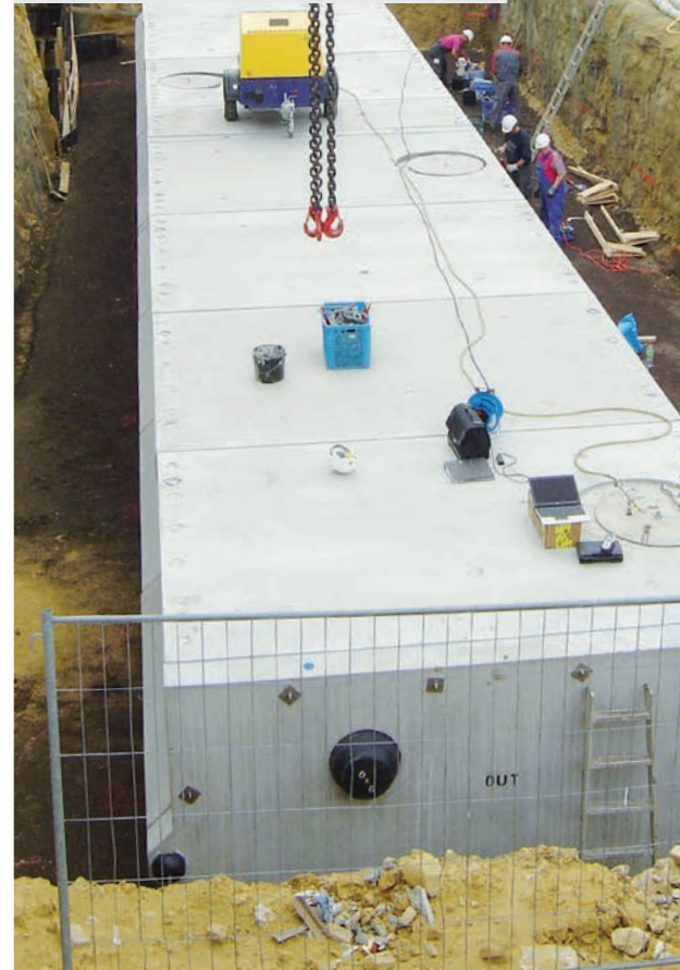
ACO Großbehälter als Havariebecken mit Feuerlöschbehälter am Stafelter Tunnel
