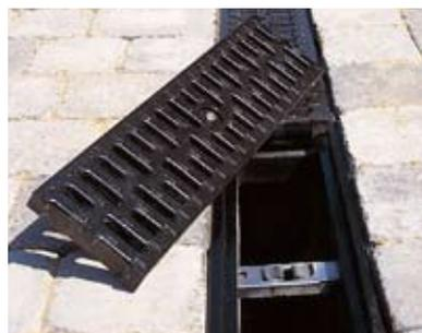
Rešetke na revizionim oknima omogućavaju jednostavno čišćenje kanala
