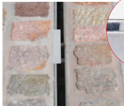
Spoj kanala sa šlic rešetkom SA spojnicom
