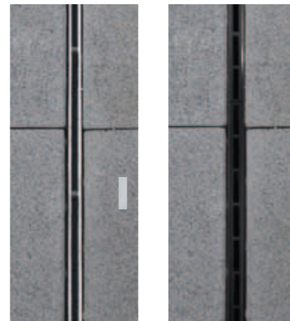
Kanal sa šlic rešetkom od nerđajućeg ili pocinkovanog čelika (levo) i od plastike (desno) za diskretno rešenje modernih betonskih i kamenih podloga.
