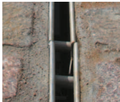
Spoj kanala sa šlic rešetkom BEZ spojnice
