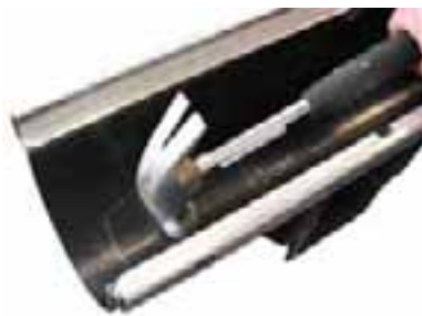
Formiranje vertikalnog izliva
