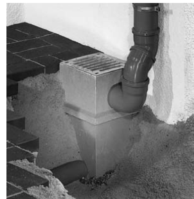
Primer ugradnje ACO Self dvorišnog slivnika s priključkom na krovnu vertikalu
