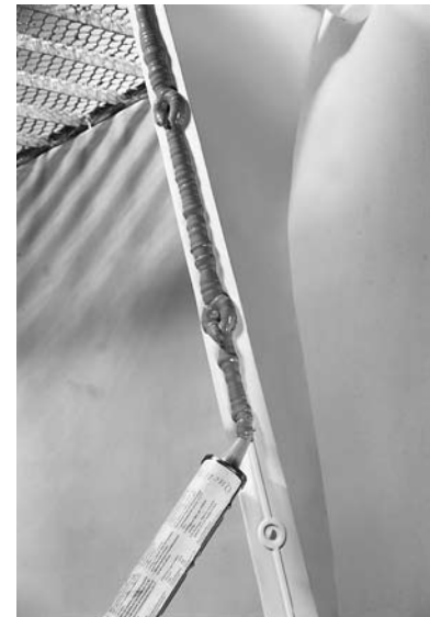
Profix masa za ugradnju svetlosnog okna sa dodatnim zaptivanjem
