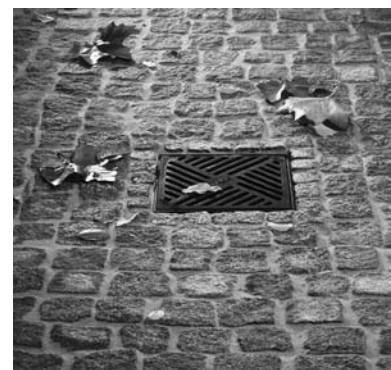
Primer ugradnje ACO Self dvorišnog slivnika
