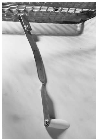
Protivprovalni element ugrađen u svetlosno okno
