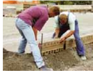
ACO Monoblock RD 100 V - Jednostavna ugradnja bez dizalica
