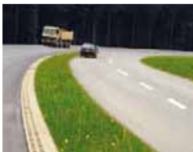
ACO Monoblock RD 200 V na autoputu kao element podužnog odvodnjavanja
