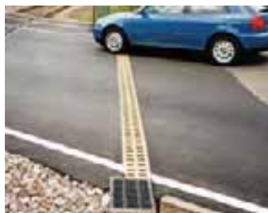
ACO Monoblock RD 100 V poprečni kanali kod železničkih prelaza
