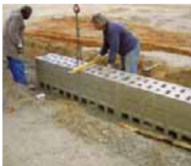
Montaža kanala ACO Monoblock RD 300
