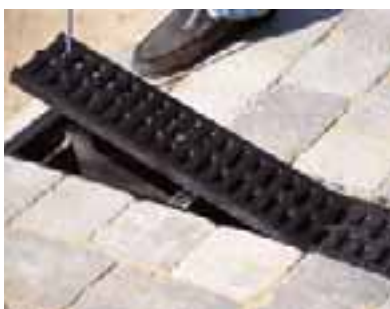
Brzo podizanje revizionih rešetki ACO podizačem za rešetke
