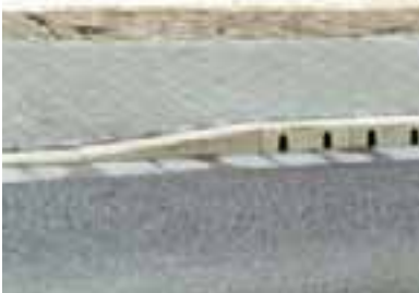
ACO KerbDrain sa spuštenim ivičnjakom, za ulaz na zemljišne parcele
