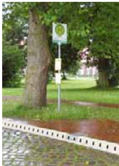
Ivičnjak i odvodni kanal u jednom elementu, ACO KerbDrain
