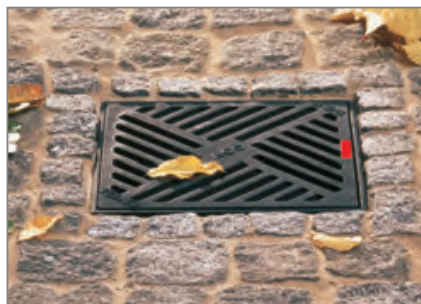
Primer ugrađenog dvorišnog slivnika
