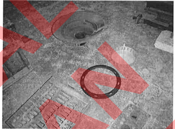
Sastavni delovi mosnog slivnika (od vrha fotografije prema dnu): donji deo slivnika, taložnik, prsten i rešetka sa ramom
